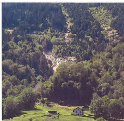
Figura 18: Zona della frana del Ri dei Mulini (UT6).
